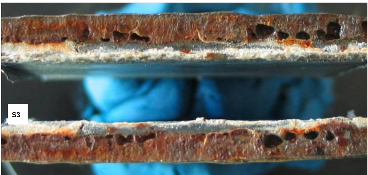
Bild 11: Längsschweißnaht im Bereich S 3 auseinandergefallen
