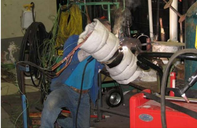
**Bild 13.** Schweißen der Verfahrensprüfung
