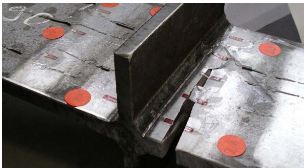
Bild 10. Bruch im Grundwerkstoff bei S690
