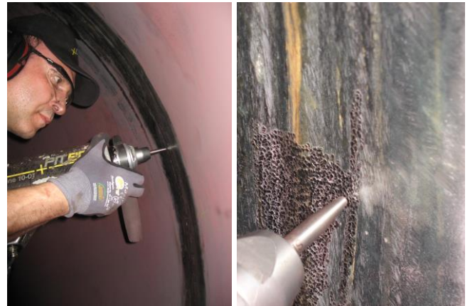
Bild 19: flächige PIT Behandlung der betr. Naht
