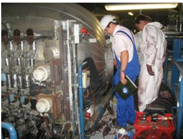
Bild 18: Außenansicht der Dampftrommel
