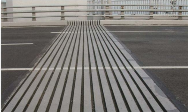
Bild 17: Brückenübergang (Dehnfuge)
