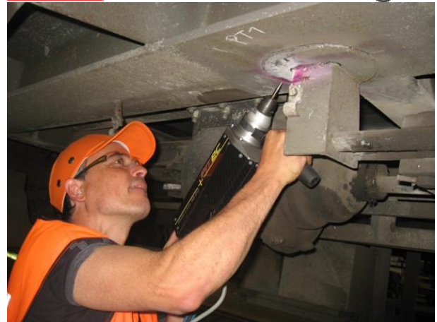
Bild 16: PIT-Behandlung Untergurt SBB Cargo
