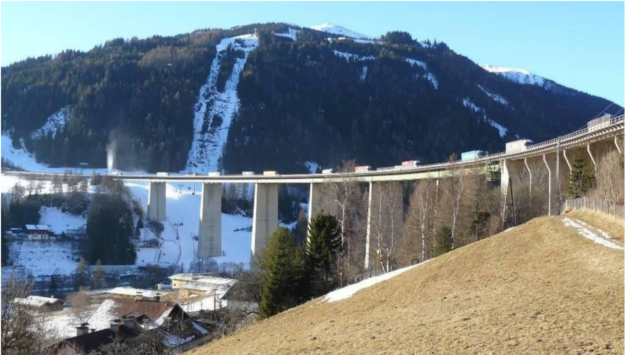
Bild 16 - sechsspurige Autobahnbrücke mit starker Verkehrsbelastung
