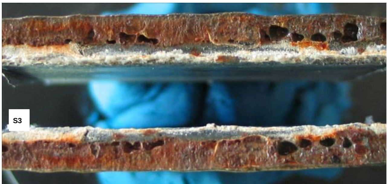
Bild 11: Längsschweißnaht im Bereich S 3 auseinandergefallen
