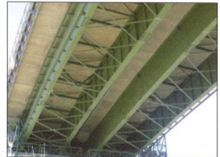
Bild 13. Stahlunterkonstruktion der Geschnitztal-Brücke.
