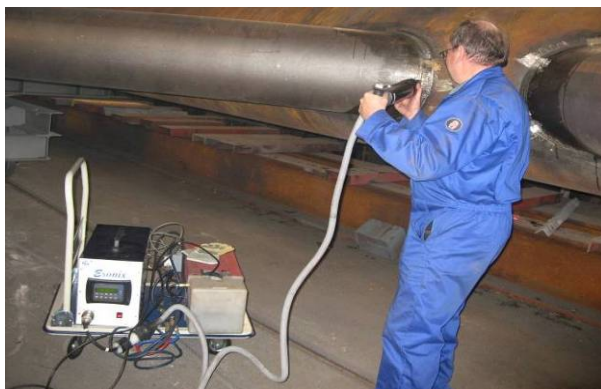
Bild 21: UIT Behandlung mit Ausrüstung
