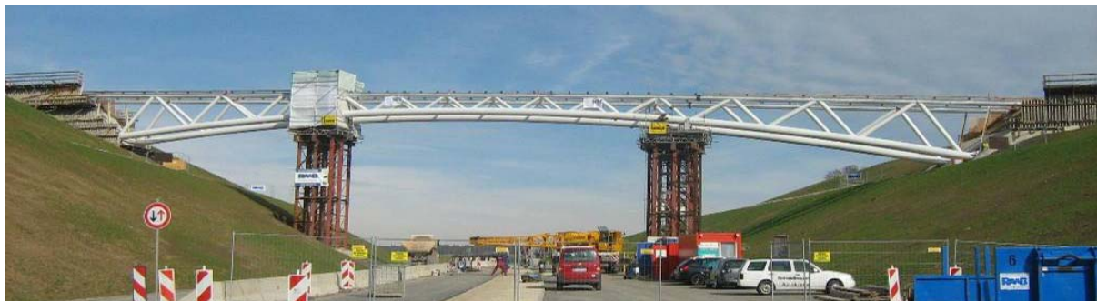
Bild 20: Straßenbrücke über die Autobahn A 73 bei Lichtenfels in der Bauphase
