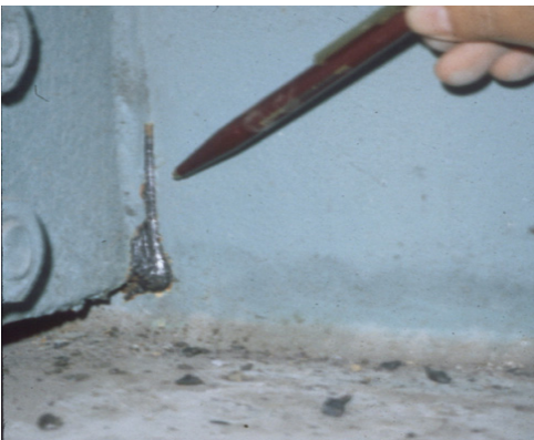
Bild 16: Quersteife UIT behandelt
