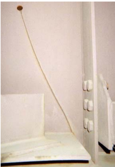
Bilder 22-24: zeigen die Reparatur eines Risses im Stegblech
