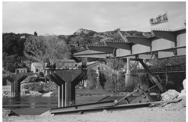
Bild 4. Verbundbrücke bei Rémoulins in der Montagephase
