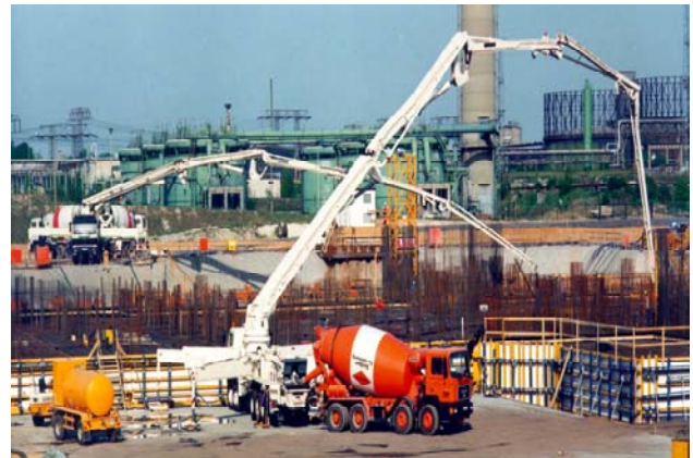
Bild 10. LKW-Betonpumpen, Verteilermaste aus PAS 700, N-A-XTRA 70 oder XABO 890, Abstützungen aus N-A-XTRA 70
