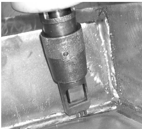
Bild 2: UIT-Behandlung des Nahtübergangs
