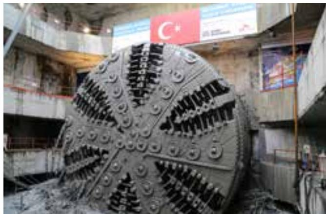
Das Schneidrad der 13,66 m grossen Tunnelbohrmaschine kurz nach dem Durchstich im Zielschacht auf der europäischen Seite des Bosphorus. Gut zu erkennen sind die verschiedenen austauschbaren Abbauwerkzeuge wie Schneidrollen und Schälmesser, die auf den 6 Hauptarmen angebracht sind.
