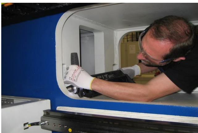
Bild 13: PIT Behandlung eines „Hotspots“
