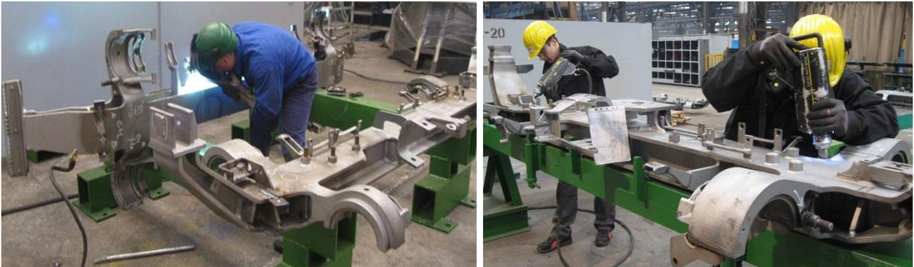
**Bild 16: Reparaturschweißung gem. Schweißanweisung Bild 17: PIT Behandlung der Hotspots**
