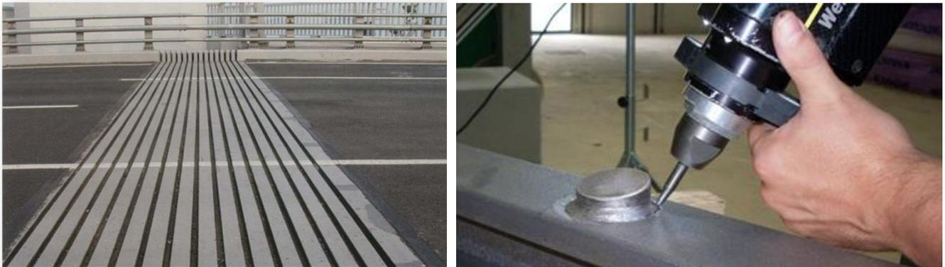
**Bild 20: Typischer Brückenübergang in der Fahrbahn Bild 21: PIT Behandlung der Hotspots Fa. Maurer**
