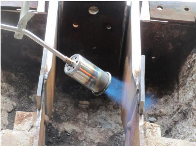
**Bild 16:** Vorwärmen des Schweißbereiches
