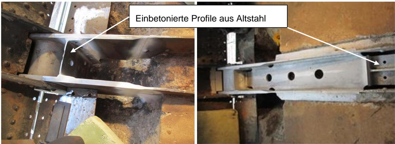
**Bild 24:** Oberflächenrissprüfungen aller Nähte    **Bild 25:** Lager fertig zum Einbetonieren
