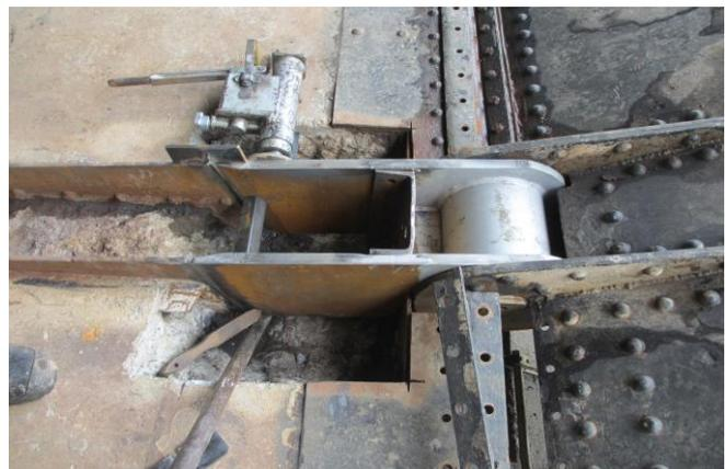
**Bild 15:** Einpassen des neuen Hauptlagers
