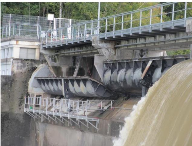
**Bild 3:** trockenengelegte Stauklappen 3 und 4
